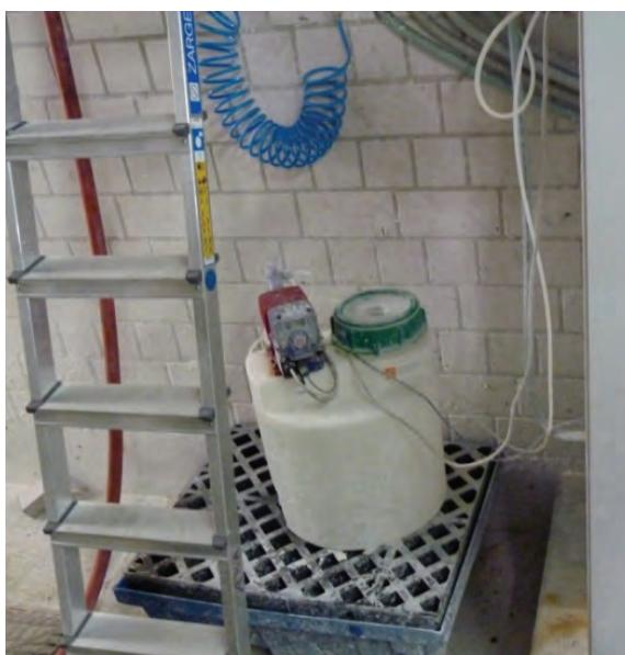
Abb. Säurespülung um Schläuche und die Probenahme zu reinigen
